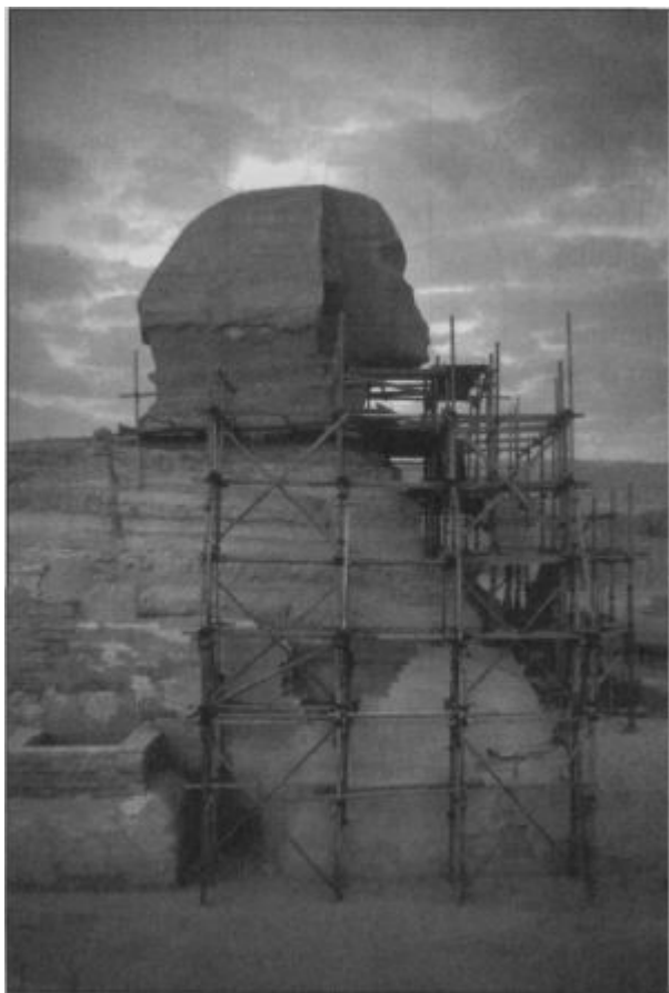
Fig. 11-6: La Esfinge con su tocado plano. El andamiaje muestra cómo la reconstrucción/estabilización se está llevando a cabo.
